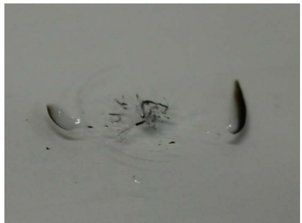
nicht fachgerecht instandgesetzt/ Lufteinschlüsse vorhanden
